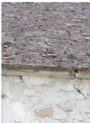
*Toitures à petites tuiles (60 à 65 par m2). Mur enduit au plâtre et traité à pierre vue pour les bâtiments utilitaires*
